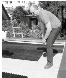
Je nach Dachgröße können die Elemente entweder auf Stoß oder mit etwas Überlappung auf der Speicherschutzmatte ausgelegt werden. Achten Sie unbedingt darauf, dass die Diffusionsöffnungen in den „Höckern“ nach oben zeigen (siehe Bild oben). Auch beim Drainage-Element ist ein entsprechendes Loch über dem Dachablauf auszuschneiden.
