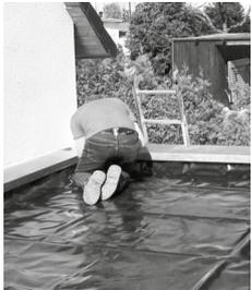
**Achtung:** Die Wurzelschutzfolie ersetzt nicht die Dachabdichtung
